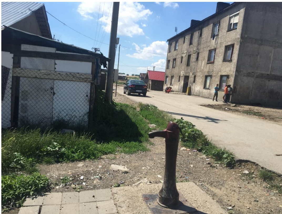
Verejný vodovod v rómskej osade v Sečovciach. V čase prieskumu bola pumpa nefunkčná
