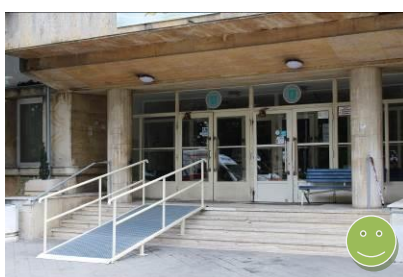
Nová rampa (Šurany), mierny sklon
