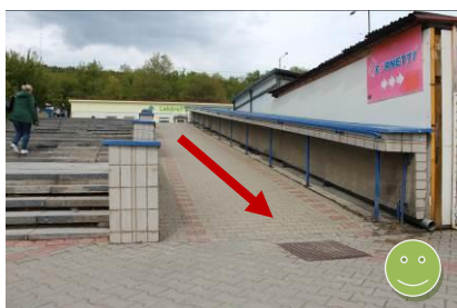
Vstup/rampa od zastávky (BB)
