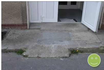
Vyrovnanie schodíka pri vstupe (TN)
