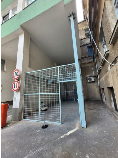
KR PZ KE: vychádzkový dvorec vo vnútrobloku budovy krajského riaditeľstva
