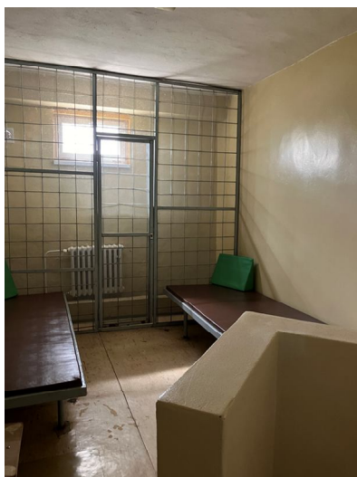
OO PZ Stará Ľubovňa: cela v nedostatočne osvetlenom suterénnom priestore
