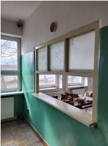
PT Opatovská Nová Ves: jedáleň (výdajné okienko)
